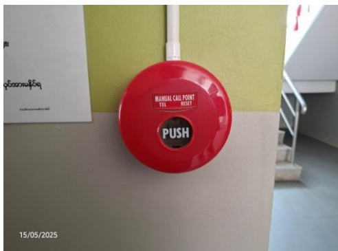
รูปที่ 2.5.9-1 อุปกรณ์แจ้งเหตุแบบใช้มือ
