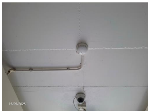
รูปที่ 2.5.9-4 อุปกรณ์ตรวจจับความร้อน
