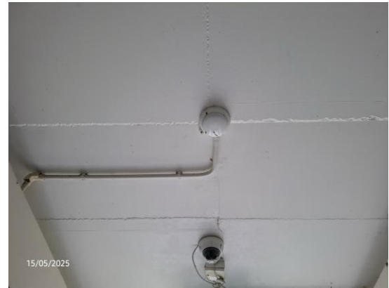
รูปที่ 3-28 เครื่องตรวจจับความร้อน (Heat Detector)
