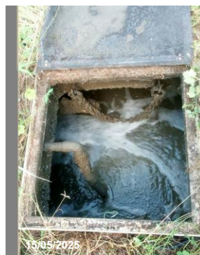
รูปที่ 2.5.3-2 ถังเติมอากาศ
