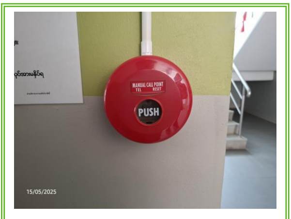
รูปที่ 3-26 ชุดกดแจ้งเหตุแบบใช้มือ (Manual Station)
