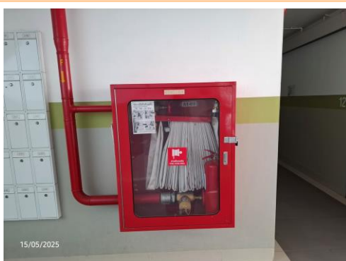
รูปที่ 2.5.9-6 ตู้เก็บสายฉีดน้ำดับเพลิง
