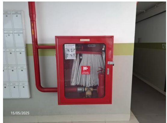
รูปที่ 3-30 ตู้เก็บสายฉีดน้ำดับเพลิง (Fire Hose Cabinet)
