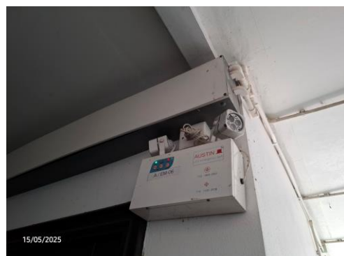
รูปที่ 2.5.9-8 ไฟส่องสว่างฉุกเฉิน
